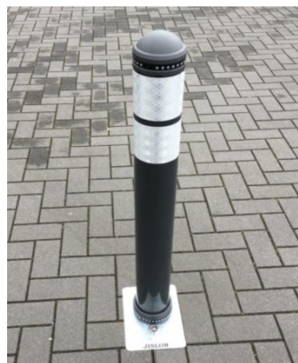
4. Draai de paal met de hand zo vast mogelijk
